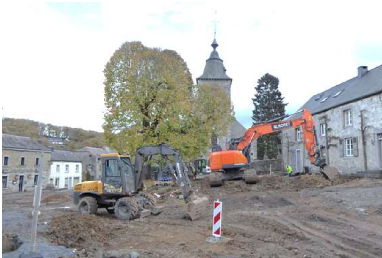
Fig. 16. Le tilleul en novembre 2022, lors des travaux d'aménagement du cœur de Crupet. © P. André.
