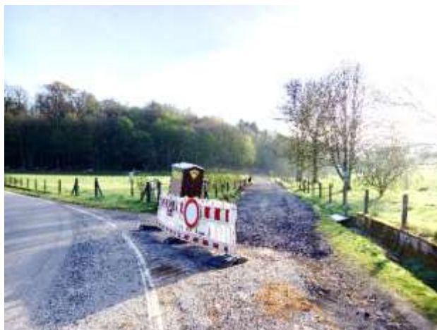
Fig. 1. Les travaux d'empierrement du ViciGAL au niveau du chemin qui longe le site de Vivaqua. © P. André, avril 2025.
