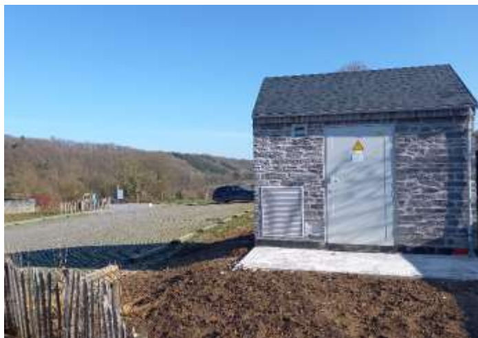
Fig. 2. La nouvelle cabine électrique sur le parking du Tige. © P. André, 2025.
