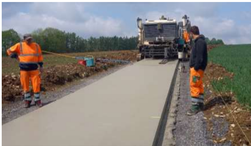
Fig 6. Un camion de béton pour 10 m de tronçon. © P. André, avril 2025.
