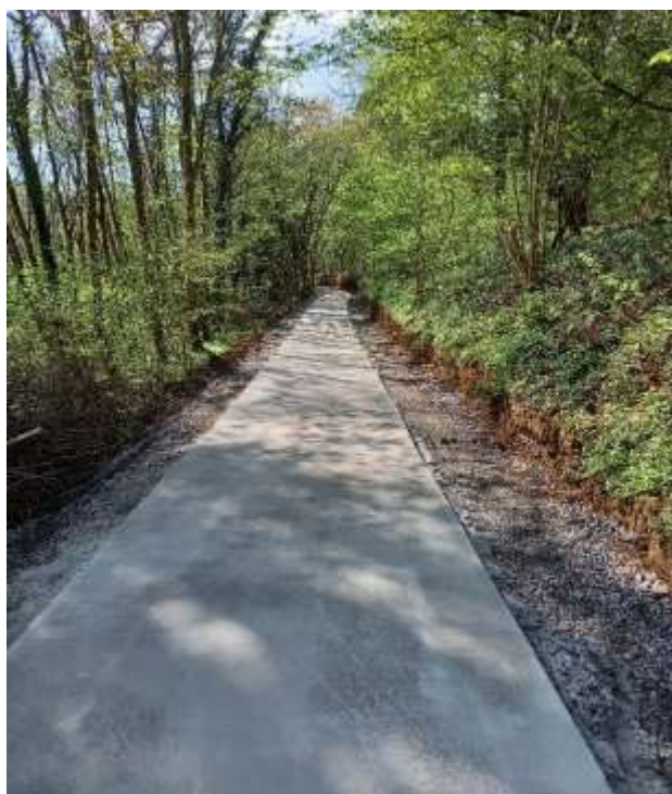
Fig. 2. Les travaux de bétonnage du ViciGAL dans la traversée du bois « Sur Chession » vers Maillen. © P. André, avril 2025.
