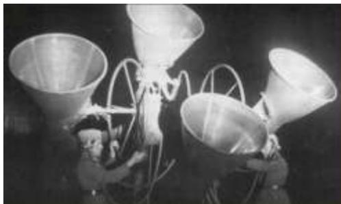
Figure 54. Au début de la guerre, avant le radar, on utilisait, de part et d'autre de la Manche, la détection acoustique d'une portée d'une quinzaine de kilomètres. © avionslegendaires.net
