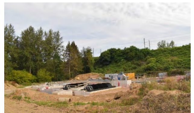
Photo 3. Station d'épuration en construction (juillet 2022).
