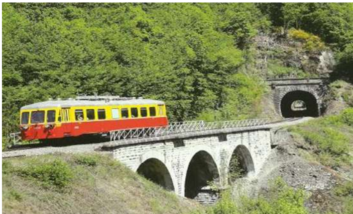
Fig. 1. La portion la plus spectaculaire de la ligne 128. L'autorail, à l'approche de Bauche, vient de franchir le Bocq sur un viaduc à 3 arches. En arrière-fond, les tunnels de Purnode (222 m), Lèche (74 m) et Durnal (314 m). © 2015 PFT.
