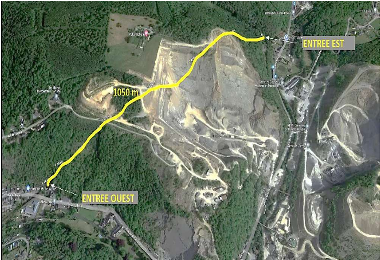
Fig. 7. Le tracé du tunnel Yvoir-Bauche dans la colline de Tricointe et les carrières d'Yvoir. © D'après une présentation de Sam Huckle, ingénieur civil des mines, Harding Prize, Londres 2024.
