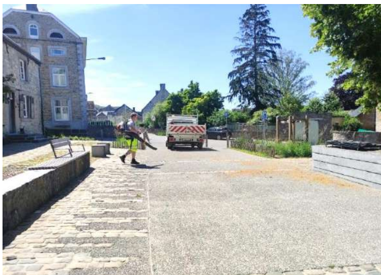
Fig. 1. Travaux d'entretien sur la place de l'église. © P.-B. Lesuisse, 2024.
