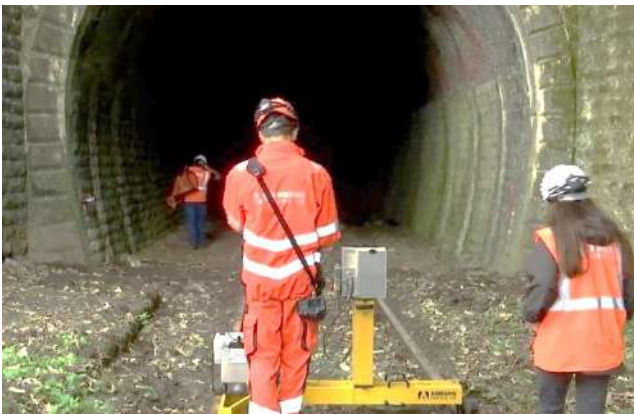
Fig. 10. Préparation du scanner 3D par la société suisse AMBER à l'entrée du tunnel. © MaTele.be, 2024.
