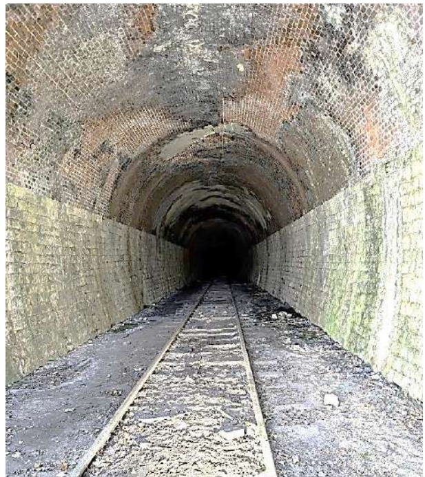
Fig. 8. Photographie de l'entrée du tunnel où l'on distingue l'appareillage de la voûte en brique et le bas des parois en moellons de pierre calcaire, mais aussi une partie des dégradations. © S. Huckle, 2024.,
